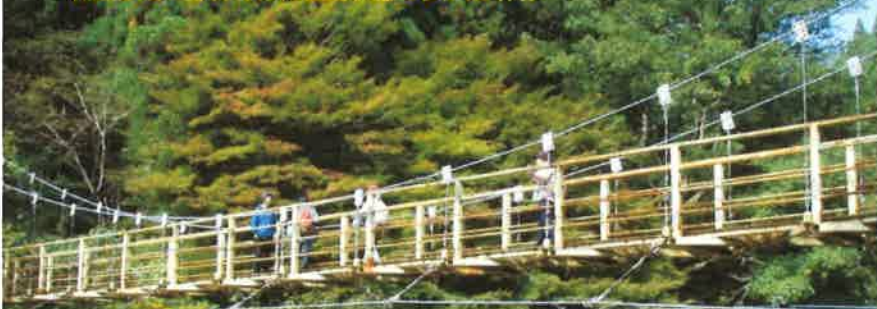
設楽町清流公園の吊橋
