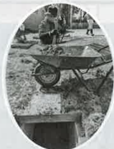
▲ プール用排水側溝の清掃
